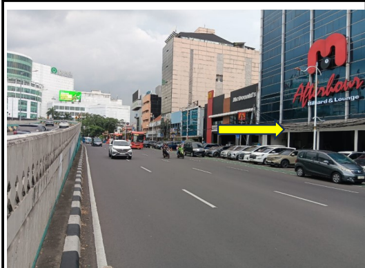
TAMPAK JALAN SULTAN HASANUDDIN DEPAN RUKO (ASET SEBELAH KANAN)
